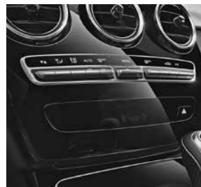
Instalație automată de climatizare
